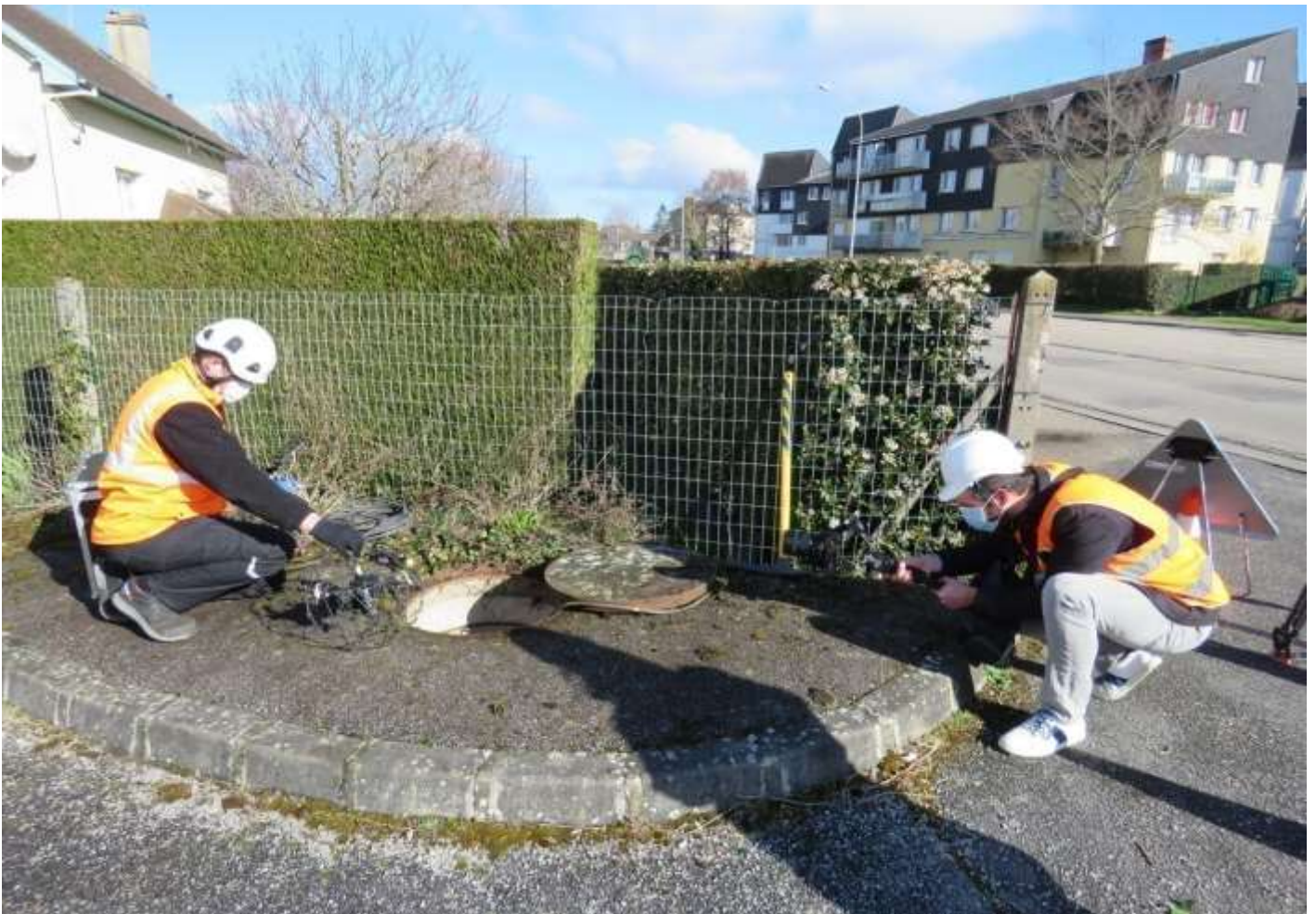
Le drone employé par Eaux de Normandie a filmé l'intérieur d'un collecteur sur 500 m à Argentan. (©Le Journal de l'Orne)
